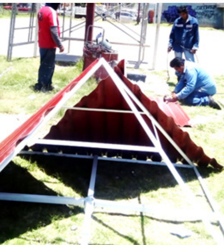
Temoltzin, I. (2019). Fotografía 1 . Colocación de lámina tipo teja para palapas dañadas en los parques de la UHSR. (26 de agosto de 2018).
